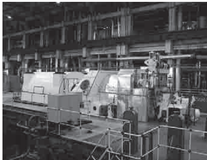
Fot. 2. Hala maszynowni
