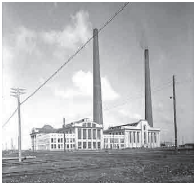
Elektrociepłownia PFZA w Mościcach
