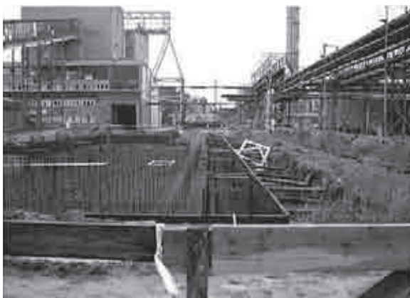
Fot. 3. Wykonywanie fundamentów do budynku głównego i suszarki bębnowej
