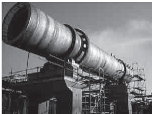
Fot. 6. Montaż urządzeń
