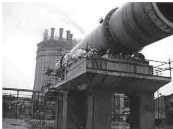
Fot. 5. Montaż urządzeń
