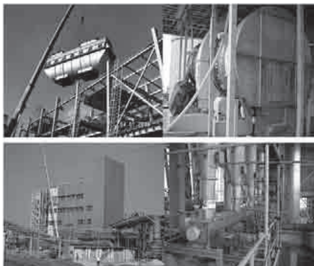
Fot. 7. Montaż aparatów urządzeń zgodnie z postępowaniem powstawania budynku instalacji
