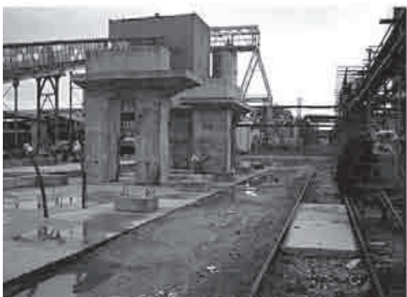
Fot. 4. Prace przygotowawcze dotyczące uzbrojenia terenu pod instalację główną
