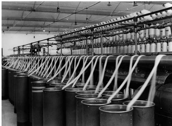
Oddział Arteks, niedoprzęd z włókien ciętych poddawany jest skręcaniu i nawijany na szpule
