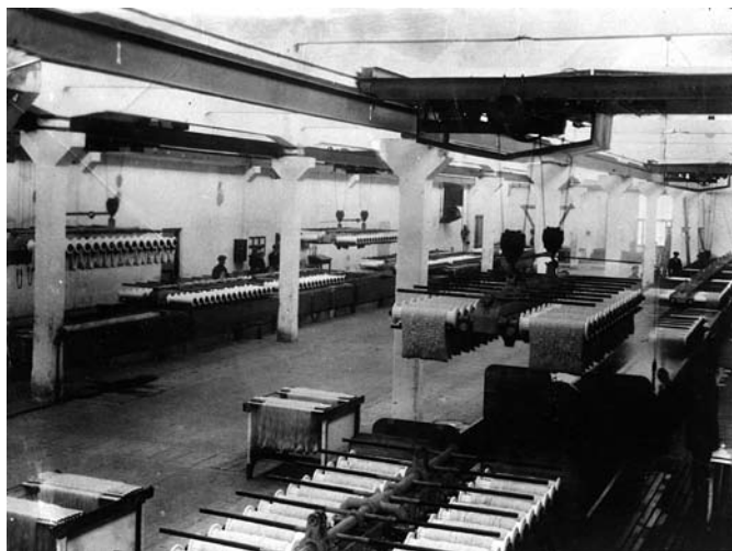
Widok wykańczalni pasmowej, jedwab w motkach, po barwieniu jest obrabiany na maszynach Gerbera
