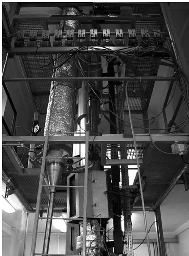
Rys. 4. Widok stanowiska badawczego do spalania paliw w cyrkulacyjnej warstwie fluidalnej
