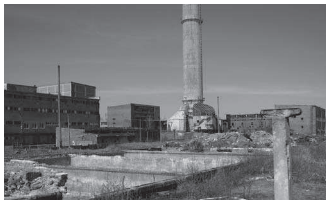
Opustoszałe budynki fabryczne, na pierwszym planie baseny po zbiornikach magazynowych dwusiarczku węgla (zbiorniki magazynowe, ze względów bezpieczeństwa, znajdowały się w basenach z wodą (1999 r.))
