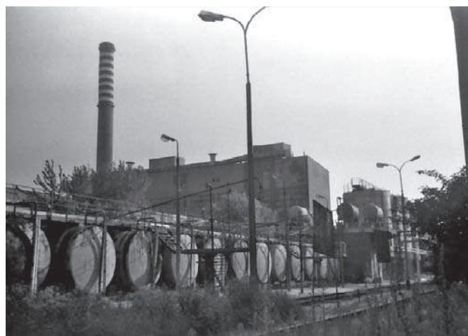
Widok na magazyn kwasu siarkowego (12 zbiorników leżących, każdy pojemności 100 m 3 , na budynku widoczne 2 zbiorniki tzw. naporowe, dalej pionowe zbiorniki ługu sodowego) widoczny budynek oddziału Wiskoza 2 oraz komin I Centralnej Stacji Wentylacyjnej (1980 r.)
