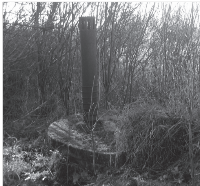
Rys. 1. Nieczynne ujęcie nr 2 w Gądeczcu, Gmina Dobrcz
