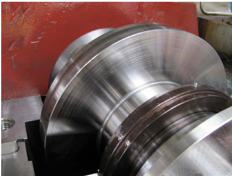
Rys. 7. Widok kołnierza łożyska oporowego w zespole wirnika turbiny po otwarciu pokrywy
