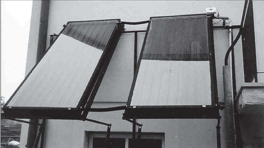
**Rys. 2.2.** Kolektory zainstalowane w instalacji przygotowania ciepłej wody domku jednorodzinny, lokalizacja – Legionowo k. Warszawy [9]
