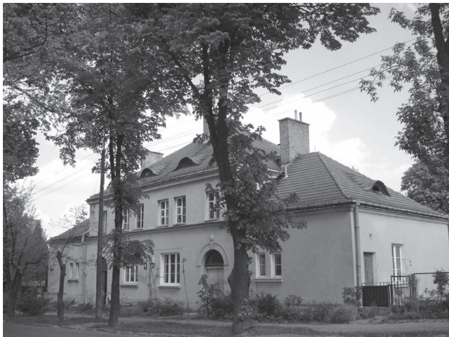
Rys. 12. Budynek typu II Ulica Czackiego.
