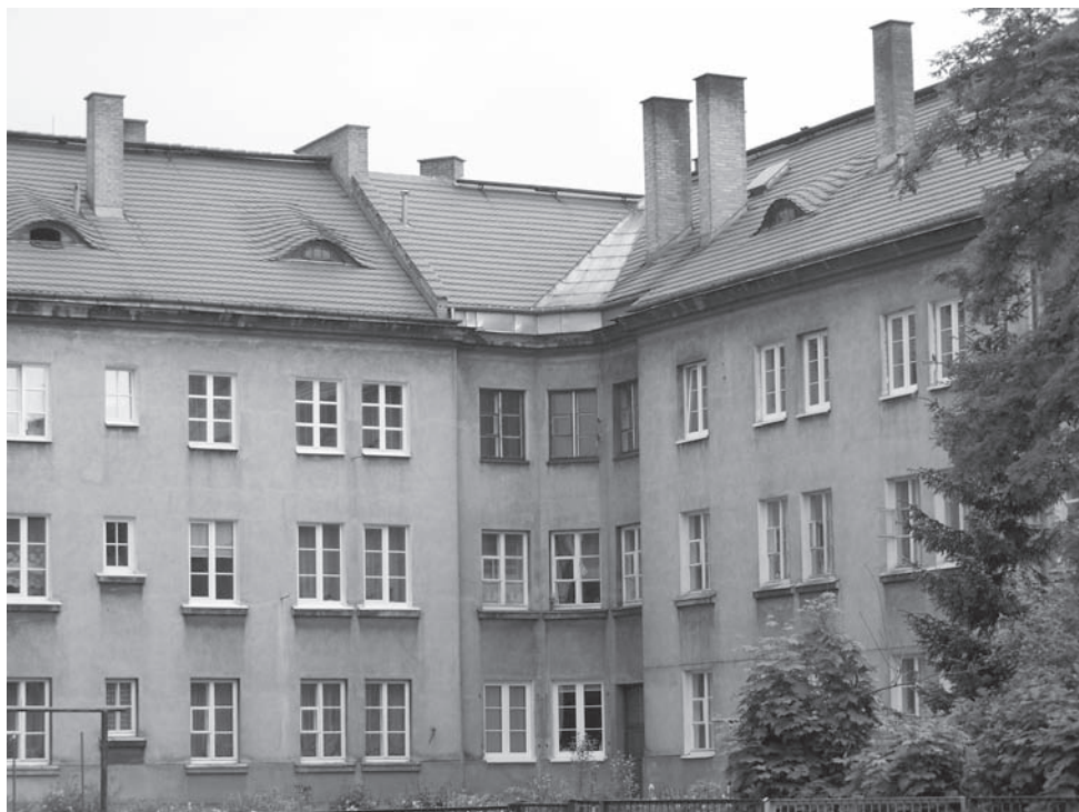
Rys. 15. Budynki typu IV i V Ulica Piłsudskiego.
