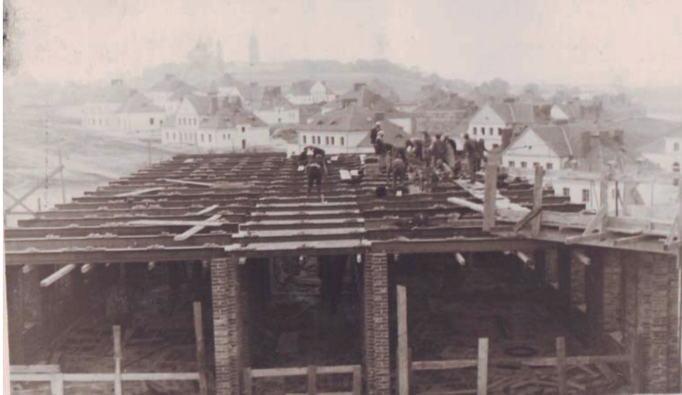
Fot. 4. Strop na belkach stalowych przed wypełnieniem przestrzeni pomiędzy belkami (ok. 1929).
