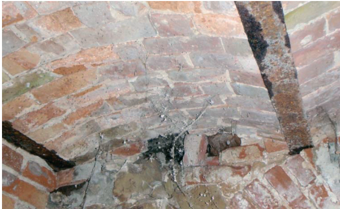
Fot. 1. Strop odcinkowy (ok. 1908r.).
