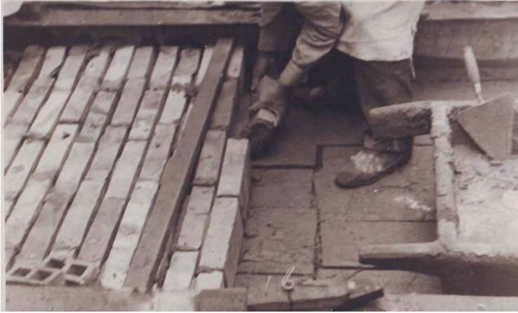
Fot. 2. Wykonywanie stropu Kleina (ok. 1928).
