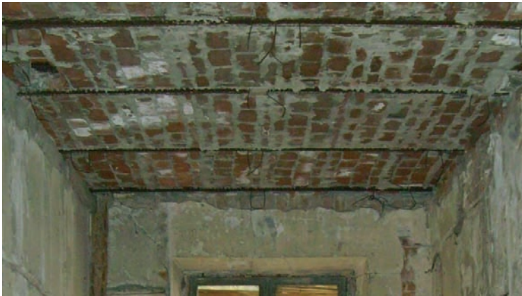
Fot. 3. Strop Kleina od spodu (widok przed otynkowaniem).
