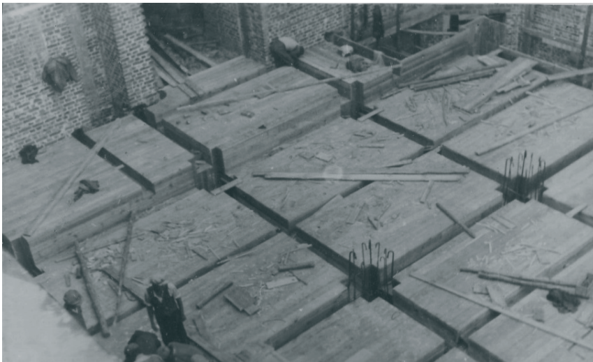
Fot. 6. Strop żebrowy, widok deskowania przed ułożeniem zbrojenia (ok. 1929).
