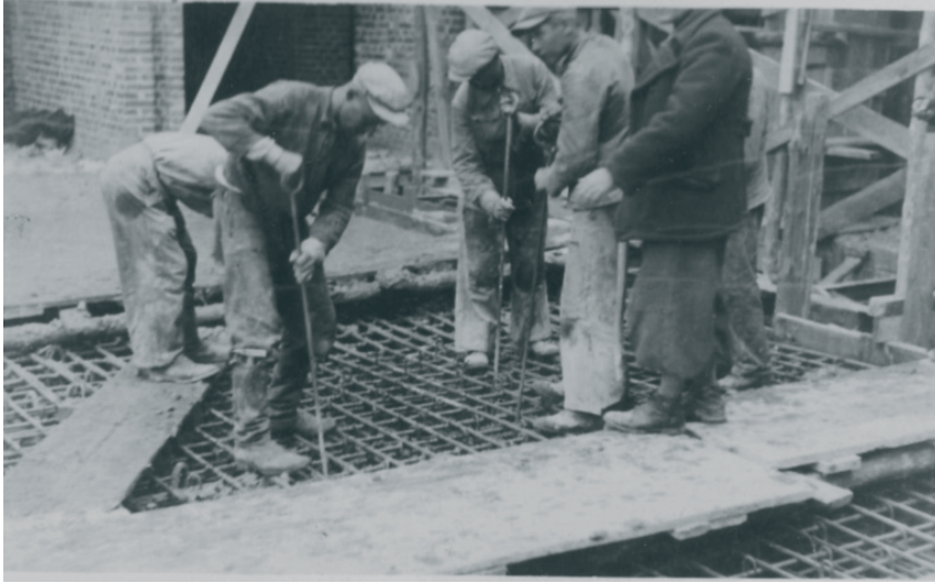
Fot. 5. Zagęszczanie betonu w stropie żebrowym (ok. 1929).
