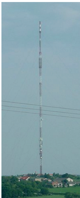
Rys. 15. Maszt o wysokości 342 m z pięcioma poziomami odciągów w Piaskach.
