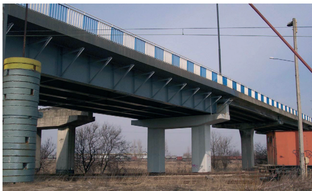
Rys. 14. Wiadukt na ulicy Grygowej w Lublinie.
