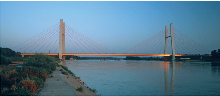
Rys. 12. Most podwieszony w ciągu trasy Siekierkowskiej w Warszawie.
