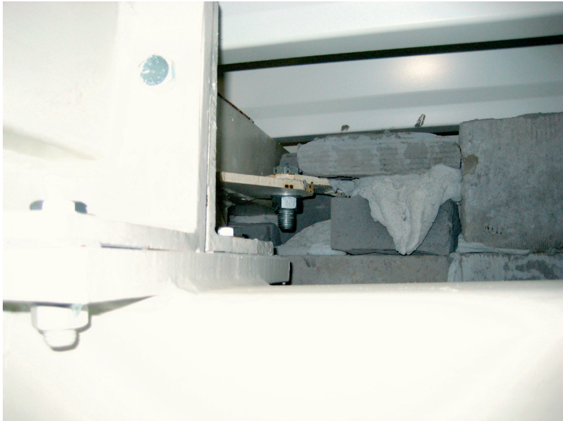
Fot. 7. Widok zabetonowanego stężenia od strony dźwigara. Photo 7. View of blocked bracing from the girder's side.
