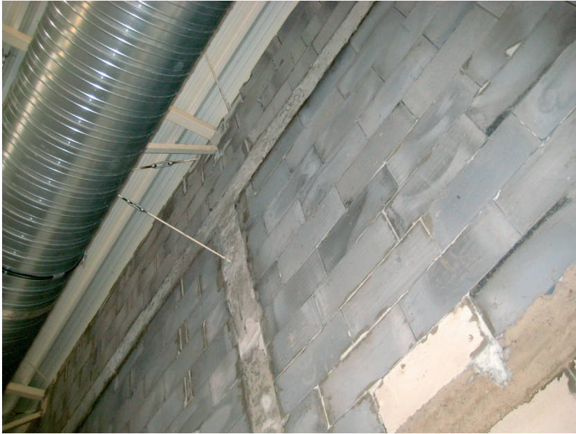
Fot. 6. Widok zabetonowanego stężenia od strony płatwi. Photo 6. View of blocked bracing from the roof beam's side.
