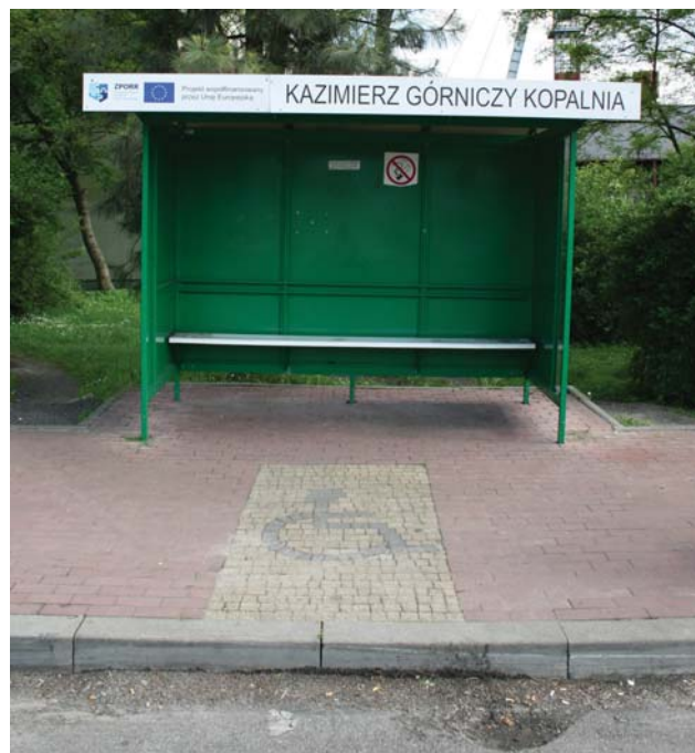
Fot. 3. Przykład oznakowania na peronie miejsca oczekiwania osób niepełnosprawnych
