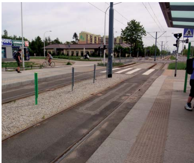
Fot. 6. Przykład oznakowania miejsca zatrzymania czoła tramwaju (zielony słupek ogrodzenia), na wysokości początku pętli indukcyjnej zamontowanej w torze Fot. A. Molecki
