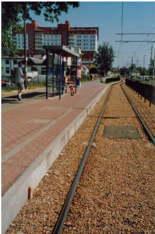
Fot. 4. Przykładowy sposób rozwiązania wyznaczenia miejsca oczekiwania niepełnosprawnych (biały kwadrat z ikoną wózka inwalidzkiego na nawierzchni peronu, niestety odległy od wiaty) oraz – odpowiednio odległego – miejsca zatrzymania czoła tramwaju (biało-czerwony słupek ukresowy na pierwszym planie) Fot. J. Makuch
