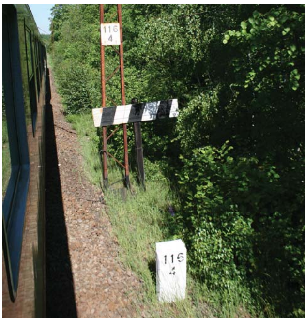
Fot. 2. Stary, wykonany z drewna wskaźnik W16
