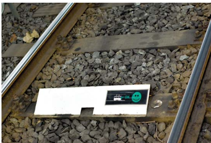
Fot. 7. Oznakowanie poziome na torowisku niezabudowanym Fot. W. Gąsior
