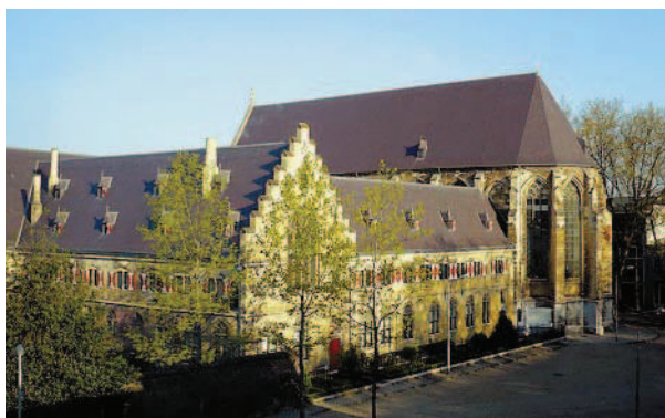
Ryc. 1. Widok na bryłę zespołu kościelno-klasztornego Kruisheren w Maastricht, (źródło: Diseño interior, N° 167, 2006) Fig. 1. View of the bulk of the church – monastery complex Kruisheren in Maastricht, (source: Diseño interior, N° 167, 2006)
