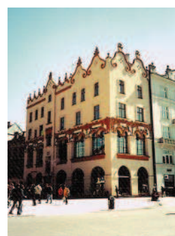
Ryc. 10. Kamienica Czyźnicela przy Rynku Głównym w Krakowie; widok z frontu Fig. 10. Czyźnicel tenement house on the Main Market Square in Krakow; front view
