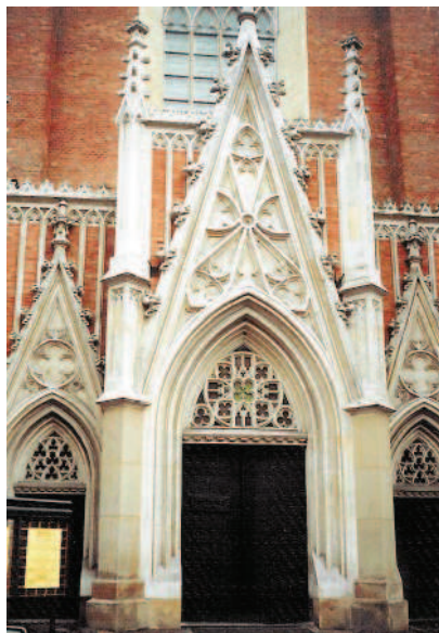
Ryc. 7. Bazylika oo. Dominikanów w Krakowie – widok portalu wejściowego Fig. 7. Dominican Basilica in Krakow – view of the entrance portal
