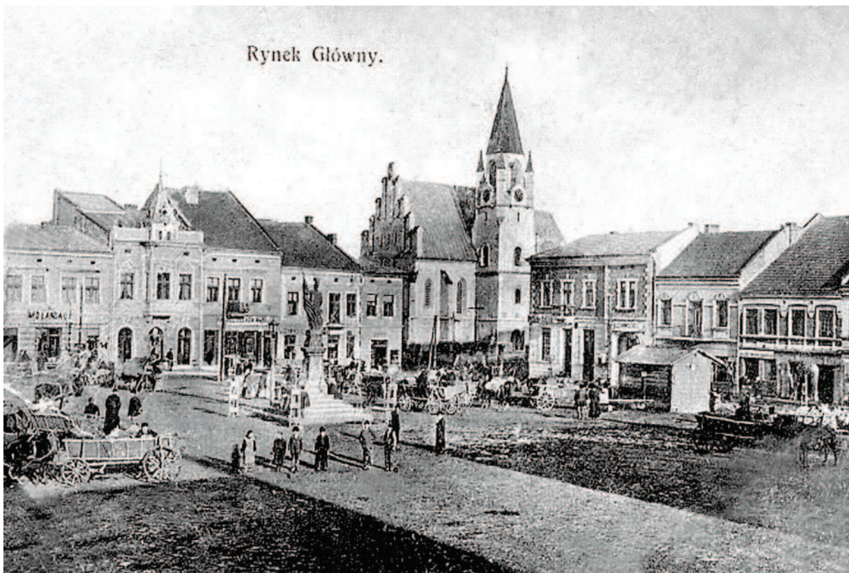
Ryc. 3. Brzesko. Fragment Rynku Głównego. Widok z pocz. XX wieku. Autor fot. nieznan (arch. IHA i KZ PK) Fig. 3. Brzesko. Fragment of the Market Square. View from the beginning of the 20 th century. Author of the photo unknown
