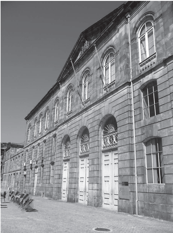
Fot. 2. Widok na fragment elewacji Alfandega Nova w Porto od strony rzeki Douro, fot. D. Kuśnierz-Krupa, 09.2012 Photo 2. View of the elevation fragment of Alfandega Nova in Porto from the river Douro, photo by D. Kuśnierz-Krupa, 09.2012
