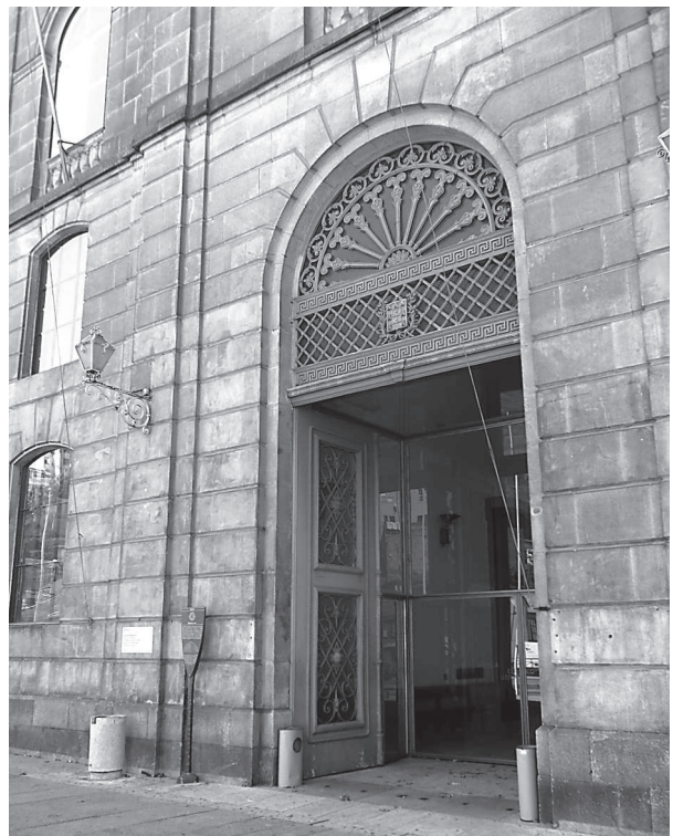
Fot. 6. Widok na fragment elewacji Alfandega Nova i wejście do budynku, fot. D. Kuśnierz-Krupa, 09.2012 Photo 6. View of the elevation fragment of Alfandega Nova and the entrance to the building, photo by D. Kuśnierz-Krupa, 09.2012
