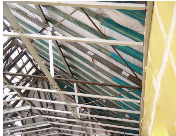
Rys. 8. Zbliżenie na konstrukcję nośną sufitu podwieszanego (opis w tekście)
