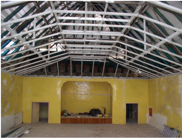
Rys. 7. Widok ogólny konstrukcji nośnej nowego sufitu
