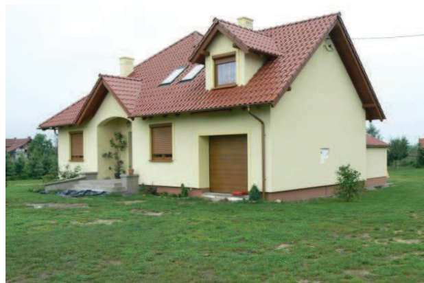
Rys. 7. Monitorowany nowy budynek Fig. 7. Monitored new building
