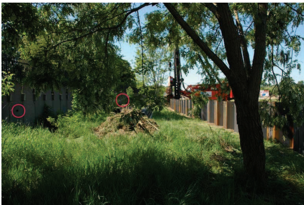
Rys. 4. Obserwacja drgań na ogrodzeniu cmentarza. Lokalizacja czujników drgań Fig. 4. Monitoring of vibrations on the cemetery wall – sensor locations
