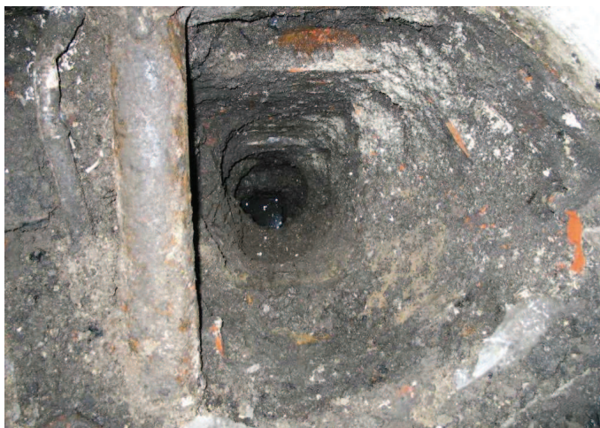
Rys. 9. Odkrywka fundamentów ceglanych Fig. 9. View of masonry foundation
