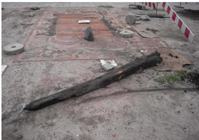
Rys. 7. Drewniany pal fundamentowy Fig. 7. Wooden foundation pile
