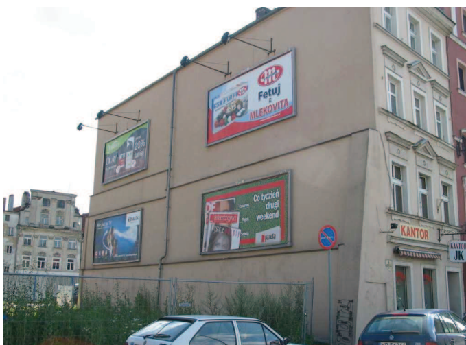
Rys. 2. Widok ściany szczytowej budynku Fig. 2. View of building gable wall
