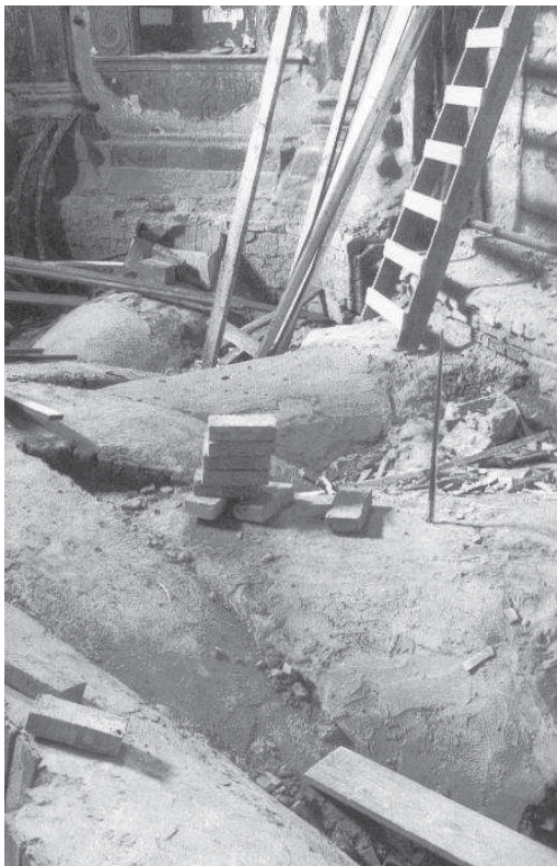
Rys. 9. Widok fragmentu odtworzonego sklepienia nad kryptą grobową od góry kaplicy Morstinów. Fot. A.J. Gaczoł, 1991 Fig. 9. The view of the fragment of the reconstructed vault over the sepulchral crypt as seen from the top of the Morstins' chapel. Photo by A.J. Gaczoł, 1991
