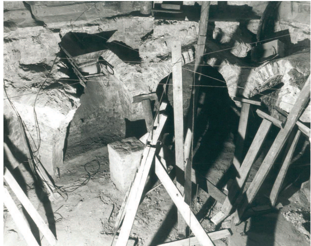
Rys. 3. Płd.-zach. część krypty pod kaplicą Morstinów po odgruzowaniu w 1991 r. Fot. J. Doraczek, ze zbiorów Archiwum WKZ w Krakowie Fig. 3. The south-western part of the crypt under the Morstins' chapel after the rubble was removed in 1991. Photo by J. Doraczek, from the archives of the WKZ in Kraków
