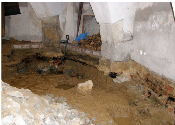
Rys. 13. Prace przy pogłębianiu krypty. W środku zdjęcia, u podstawy żebra widoczne szczątki szkieletów, które zostały pochowane pod posadzką krypty. Widoczna również woda gruntowa, zbierająca się w wykopach. Fot. A.J. Gaczoł, 2009 Fig. 13. The works aiming at deepening the crypt. In the centre: the remains of the skeletons, buried under the floor of the crypt, at the foundation of the rib and the ground water gathered in the ditch. Photo by A.J. Gaczoł, 2009
