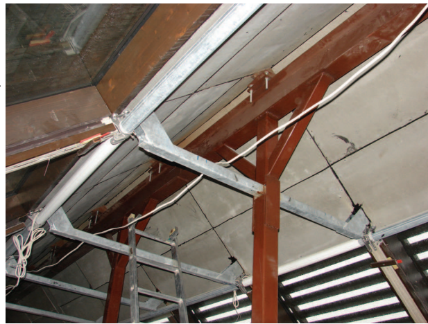
Rys. 5. Wykonane wzmocnienie dachu Fig. 5. Roof ridge after strengthening
