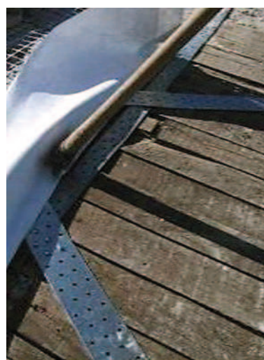
Fig. 18. Strengthening interventions, in-plane stiffening of existing wooden floors: metallic belts reinforcing wooden roof Rys. 18. Interwencje wzmacniające, usztywnienie istniejącego drewnianego stropu w płaszczyźnie: metalowe pasy wzmacniające drewniany strop
