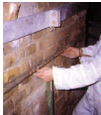
Fig. 9. Strengthening interventions, reinforced mortar repointing Rys. 9. Interwencje wzmacniające, wzmocnione punktowe naprawy zaprawą murarską
