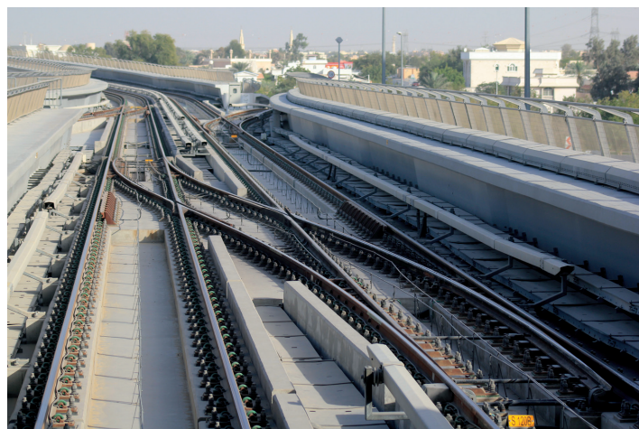
Tory położone na betonowych płytach, zwracają uwagę nowoczesne napędy zwrotnicowe (23.02.2012 r.)
