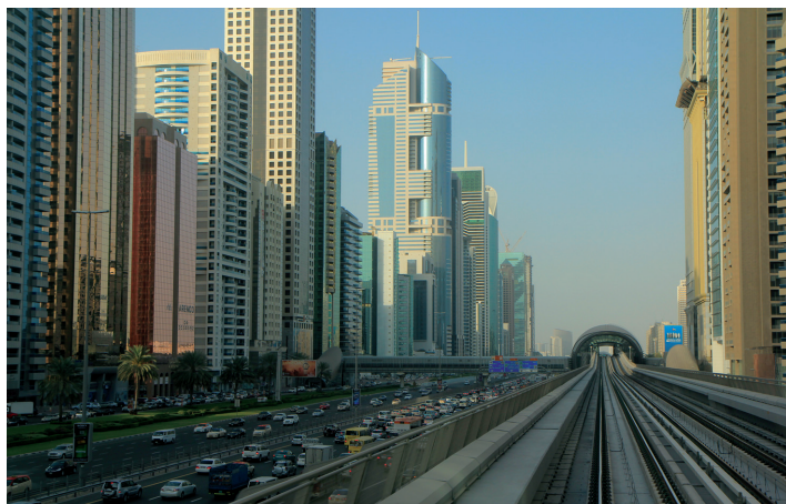
Linia metra położona przy ul. Szejka Zajeda (18.02.2012 r.)
