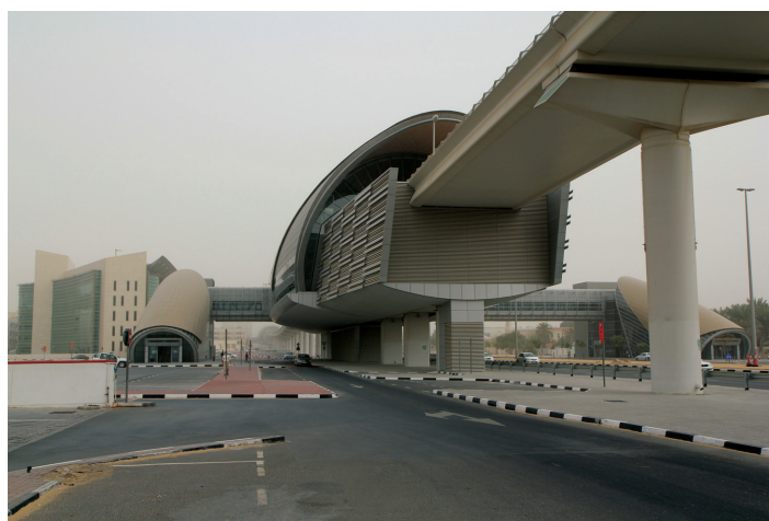
Stacja i linia metra położone na estakadach (17.02.2012 r.)
