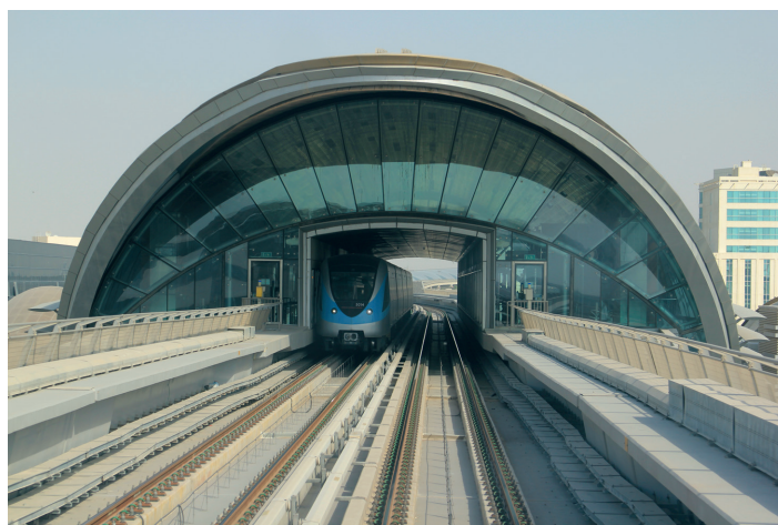
Stacja metra w kształcie muszli (18.02.2012 r.)
