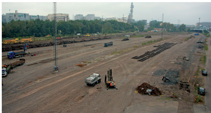
Fot. 10. Demontaż torów dawnej stacji postojowej Pasila umożliwił odzyskanie doskonale skomunikowanego terenu na potrzeby inwestycji deweloperskich; w tle osiedle Pasila-Zachód pochodzące z lat 80. Fot.: autor, 2010
