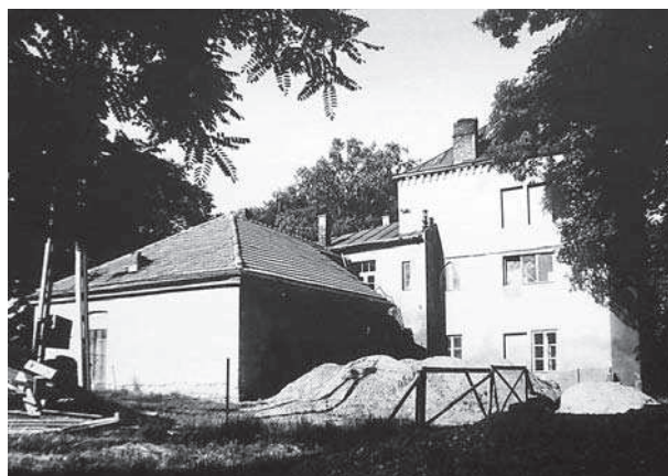
Ryc. 4. Dwór w Boratynie. Widok na elewację wschodnią przed remontem, fot. J. Salamon, 1987, w: I. Zając, Boratyn. Założenie dworsko-parkowe , op. cit., il.6 Fig. 4. Manor house in Boratyn. View of the east elevation before the renovation, photo by J. Salamon, 1987, in: I. Zając, Boratyn. Założenie dworsko-parkowe , op. cit., il.6
