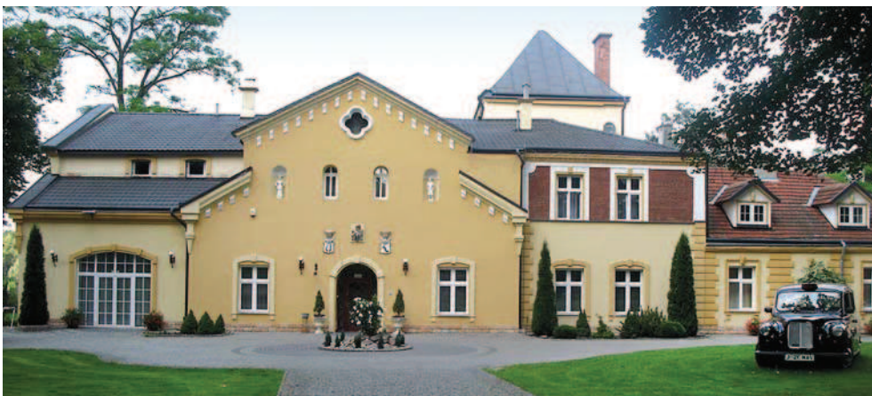
Ryc. 6. Dwór w Boratynie. Widok na dawną elewację tylną – południową po remoncie. Elewacja ta pełni obecnie funkcję elewacji frontowej – tutaj znajduje się wejście do dworu, fot. J. Kobylarczyk 2011
