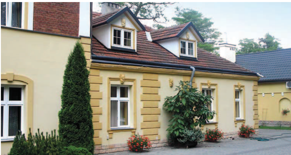
Ryc. 7. Dwór w Boratynie. Widok na fragment dawniej elewacji tylnej – południowej po remoncie, fot. J. Kobylarczyk 2011
