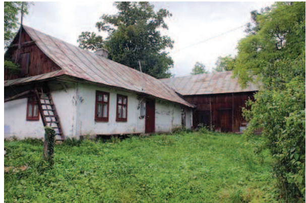
Ryc. 2. Dom drewniany nr 18 Fig. 2. Timber house no 18
