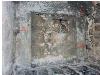
Ryc. 3. Wnętrze wnęki: a) haki po zawiasach drzwiczek, b) otwór do zasuwki, c) zamurowanie z ok. 1594 r.
