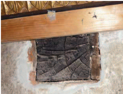
Ryc. 2. Gniazdo z fragmentem spalonej belki pochodzącej z pierwotnego stropu
