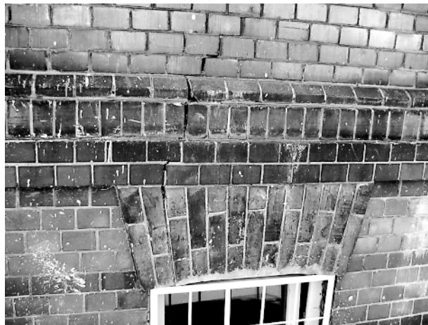
Ryc. 10, 11. Uszkodzenia murów i nadproży w rejonie otworów okiennych. Zły stan techniczny obróbek blacharskich [2] Fig. 10, 11. Damage to walls and lintels in the area of window openings. Poor technical condition of flashing [2]
