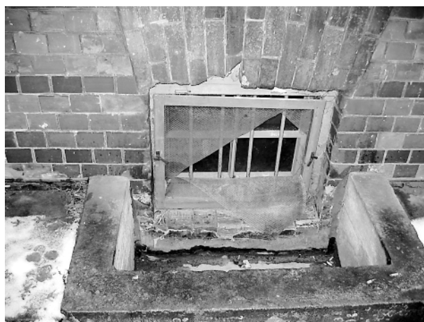
Ryc. 14, 15. Strefa przyziemia budynku. Stan techniczny cokołu, koszy okien piwnicznych. Brak prawidłowych izolacji przeciwwodnych i odprowadzenia wód opadowych [2] Fig. 14, 15. Basement zone of the building. Technical condition of the set-off and cellar windows embrasures. Lack of proper waterproofing and precipitation draining [2]
