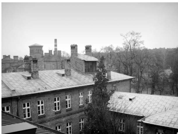
Ryc. 12, 13. Dach pokryty blachą stalową ocynkowaną. Zły stan techniczny pokrycia, obróbek blacharskich i kominów (zdjęcia autorów) Fig. 12, 13. Roof covered with zinc-coated steel sheets. Poor technical condition of roof covering, flashing and chimneys (photos by authors)
