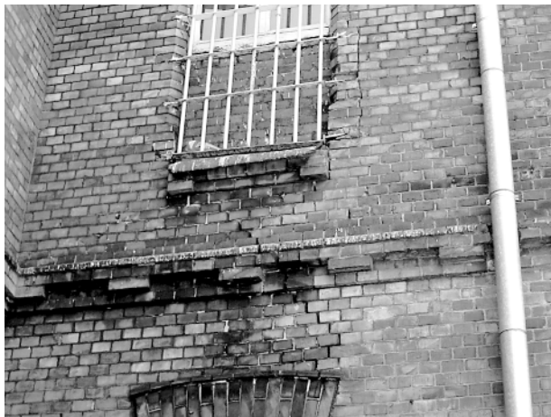
Ryc. 10, 11. Uszkodzenia murów i nadproży w rejonie otworów okiennych. Zły stan techniczny obróbek blacharskich [2] Fig. 10, 11. Damage to walls and lintels in the area of window openings. Poor technical condition of flashing [2]
