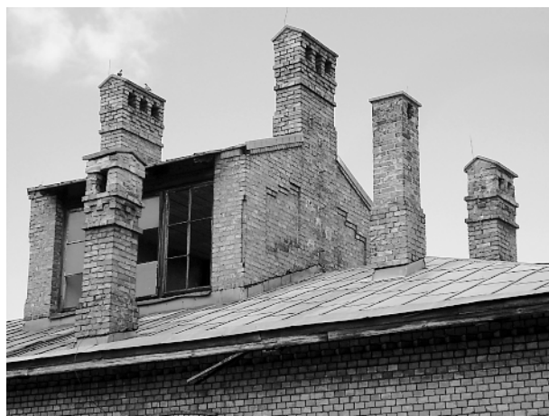
Ryc. 12, 13. Dach pokryty blachą stalową ocynkowaną. Zły stan techniczny pokrycia, obróbek blacharskich i kominów (zdjęcia autorów) Fig. 12, 13. Roof covered with zinc-coated steel sheets. Poor technical condition of roof covering, flashing and chimneys (photos by authors)
