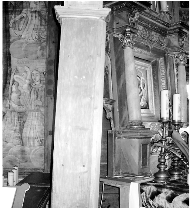
Ryc. 5. Binarowa. Widoczne deformacje geometrii ścian i ołtarza bocznego. Fot. Jan Janczykowski, czerwiec 2010 Fig. 5. Binarowa. Visible deformations of the walls and side altar geometry. Photo Jan Janczykowski, June 2010
