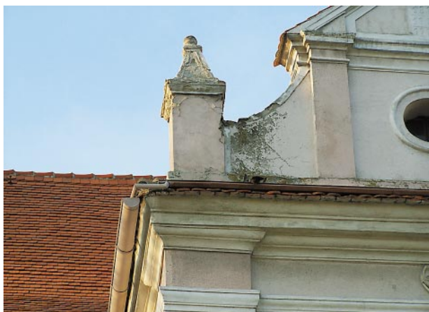
Ryc. 5, 6. Uszkodzenia murowanych elementów attyk oraz ścian Fig. 5, 6. Damage to masonry elements of attics and walls
