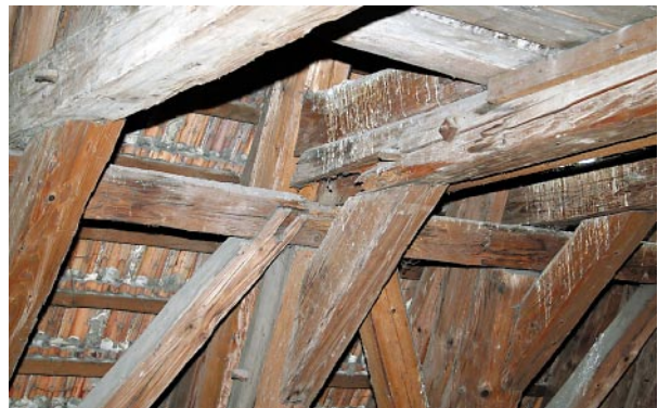
Ryc. 5. Jętka wzmocniona jednostronną nakładką drewnianą łączoną za pomocą śrub. Przekrój jętki w połączeniu całkowicie zniszczony przez grzyby Fig. 5. Collar beam strengthened with a one-side wooden cover plates fixed with bolts. Cross section of the collar beam in the joint completely destroyed by fungi
