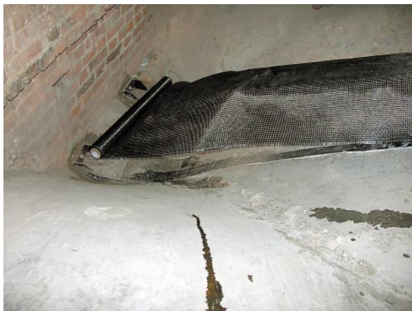
Ryc. 16. Instalacja taśm CFRP oraz siatek FRCM na żebrze sklepienia Fig. 16. Installation of CFRP tapes and FRCM meshes of the vault rib
