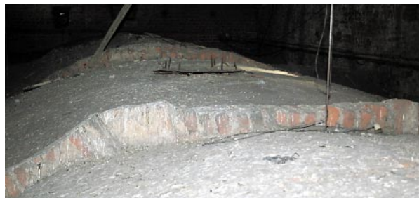
Ryc. 11. Sklepienie nad prezbiterium. Widoczne poprzeczne ceglano-żebra Fig. 11. Vault over the presbytery. Crosswise brick ribs are visible
