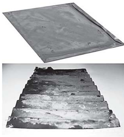
Ryc. 3. Blachy miedziane ze starego poszycia dachowego Pałacu Karola Poznańskiego w Łodzi (górna fotografia) i Pałacu w Wilanowie w Warszawie (dolna fotografia) Fig. 3. Copper sheets from old roofing of Charles Poznański Palace in Łódź (upper photo) and Wilanów Palace in Warsaw (bottom photo)
