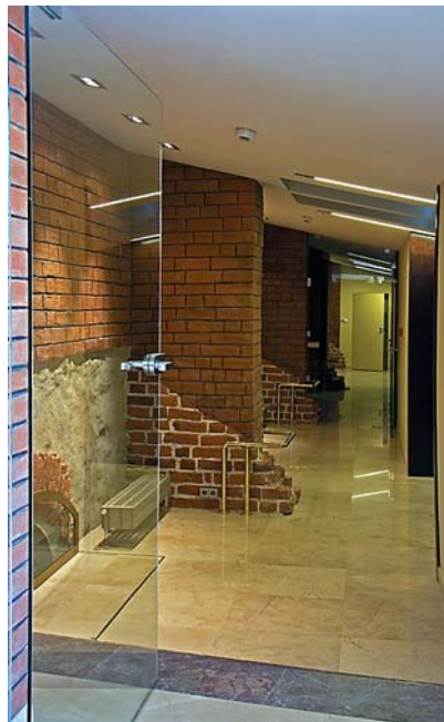
Ryc. 12. Pomieszczenie cafe baru z ekspozycją konserwowanych wątków gotyckich Fig. 12. Coffee bar room with the exhibition of the preserved Gothic bonds
