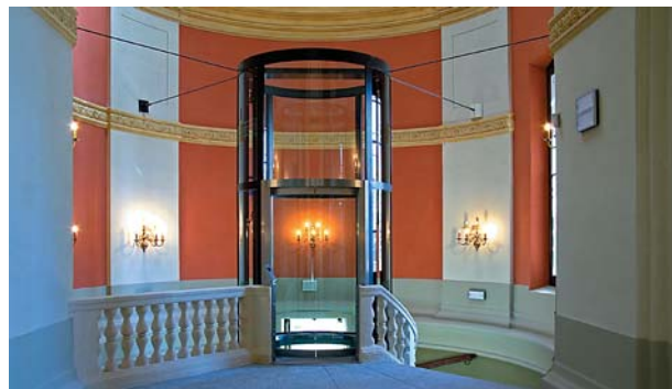
Ryc. 19. Widok windy panoramicznej wkomponowanej w reprezentacyjne schody Prylińskiego Fig. 19. View of the panoramic lift fitted into the formal staircase by Pryliński
