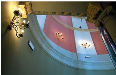
Ryc. 5. Nowa kolorystyka klatki schodowej odтворzona na podstawie badań stratygraficznych Fig. 5. New colour scheme of the staircase recreated on the basis of stratigraphic research
