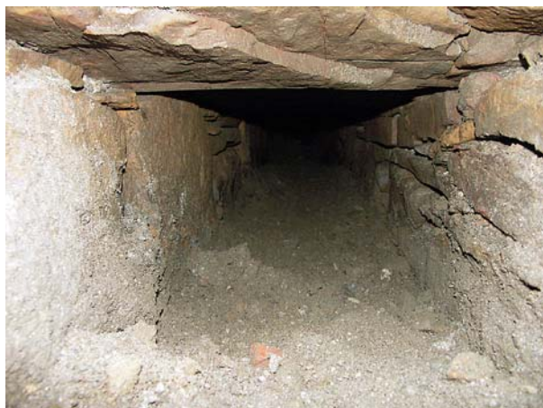
Ryc. 18. Widok wnętrza kanału odwadniającego wzdłuż skrzydła południowego; boczne ściany, dno oraz sklepienie kanału wykonane zostały z płaskich płyt piaskowca. Fot. B. Kwiatkowska-Kopka, 2004 Fig. 18. View of the inside of the drainage canal along the south wing; the sides, bottom and the ceiling of the canal were made from flat sandstone slabs. Photo B. Kwiatkowska-Kopka, 2004
