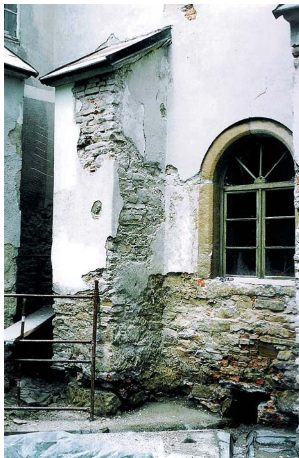
Ryc. 15. Elewacja północna z lokalizacją sondy nr 1, odcinek A i B. Pod oknem w skrajnej lewej osi parteru widoczny otwór wlotowy kanału odwadniającego wirydarz. Oprac. A. Bojęś-Białasik Fig. 15. North elevation with location of probe no 1, section A and B. Inlet of the canal draining the garth is visible under the window in the extreme left ground floor axis. Made by A. Bojęś-Białasik
