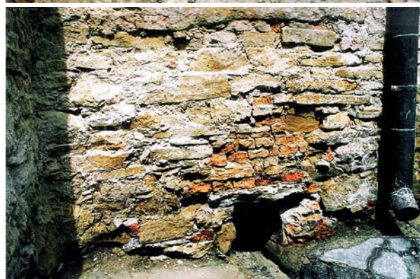
Ryc. 16. Wlot kanału odpływowego w ścianie północnej wirydarza; widok wlotu kanału po zbitiu tynku z elewacji oraz podczas kontynuacji prac remontowych. Fot. B. Kwiatkowska-Kopka, 2004 Fig. 16. Inlet of the drainage canal in the north wall of the garth; view of the canal inlet after hacking off plaster from the elevation and during the continuing renovation work. Photo B. Kwiatkowska-Kopka, 2004
