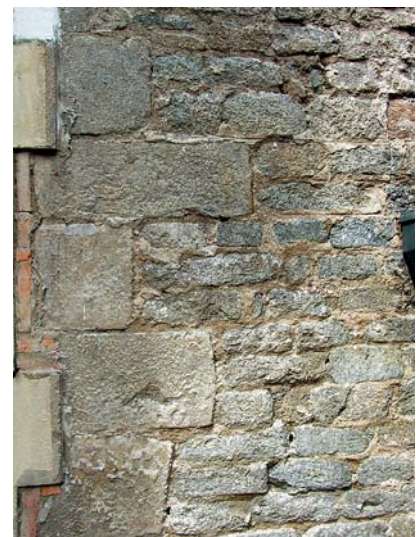
Ryc. 10. Zewnętrzny narożnik południowo-zachodni budowli romańskiej zachowany w południowej elewacji zamku. Fot. K. Stala Fig. 10. External south-west corner of the Romanesque building preserved in the south elevation of the castle. Photo: K. Stala
