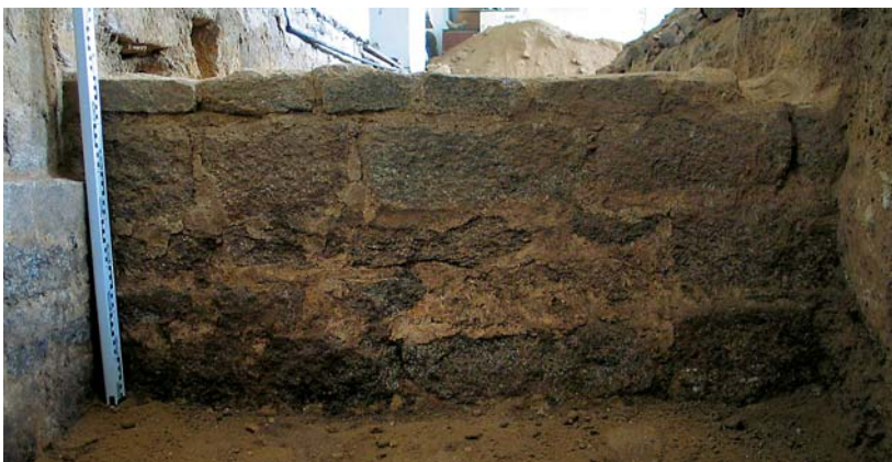
Ryc. 8. Widok na odsłonięte lico muru poprzecznego (tzw. Sala Rycerska). Fot. K. Stala Fig. 8. View onto the uncovered face of the crosswise wall (the so called Knight's Room). Photo: K. Stala
