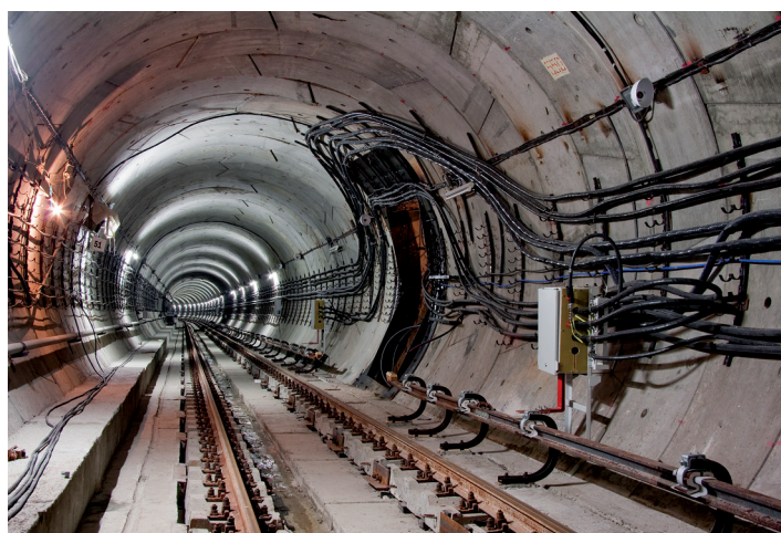
Budowa metra na odcinku Łybidśka – Wasilkiwska, linia Kureniwsko-Krasnoarmijska (31.10.2010 r.) Fot. Oleg Tockij
