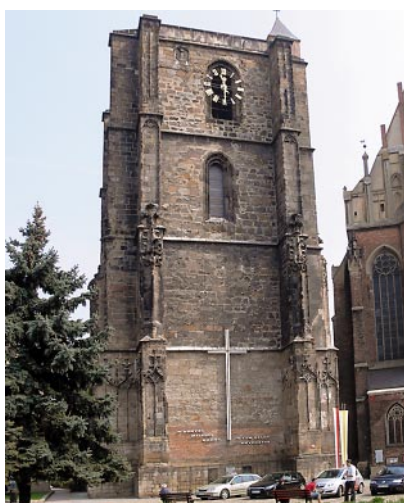
Ryc. 13. Elewacja południowo-wschodnia (rok 2011) Fig. 13. South-eastern elevation (2011)
