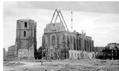
Ryc. 6. Odbudowa kościoła farnego i dzwonnicy (rok 1956) Fig. 6. Rebuilding the parish church and bell tower (1956)
