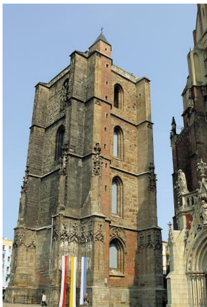
Ryc. 15. Elewacja południowo-zachodnia (rok 2011) Fig. 15. South-western elevation (2011)
