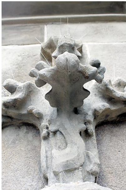
Ryc. 30. Zrekonstruowany w sztucznym kamieniu element przypory wschodniej (wraz z zabezpieczeniem przeciw ptakom, konserwacja w 2009 roku) Fig. 30. Element of the eastern buttress reconstructed in artificial stone (together with the mesh protecting it against birds, conservation in 2009)
