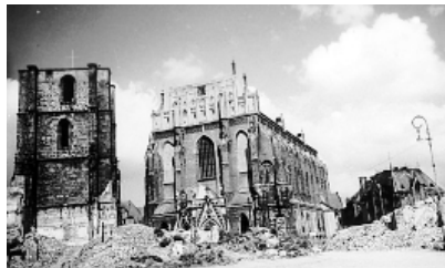
Ryc. 5. Zniszczenia kościoła farnego i dzwonnicy oraz otaczających zabudowań (początek lat 50. XX w.) Ryc. 5. Damage to the parish church, bell tower and the surrounding buildings (beginning of the 1950s)
