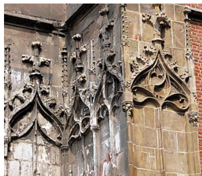
Ryc. 17. Uszkodzona i odnowiona dekoracja rzeźbiarska elewacji przypór południowych (rok 2011) Fig. 17. Damaged and renovated sculpting decoration of the elevation and southern buttresses (2011)
