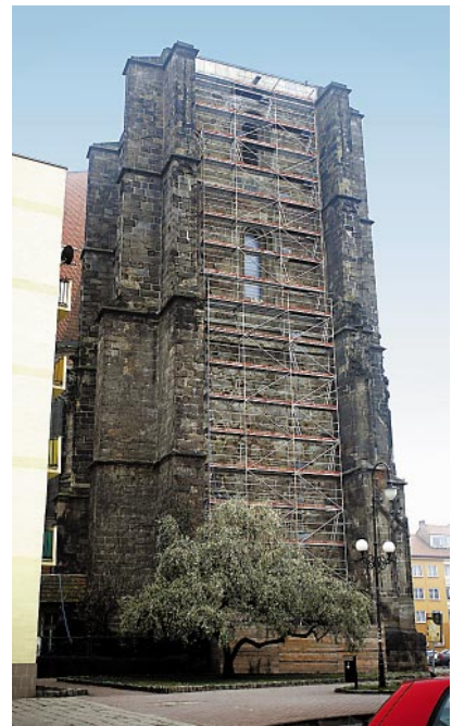
Ryc. 36. Elewacja od strony północno-zachodniej – prace konserwatorskie prowadzone w 2010 roku
