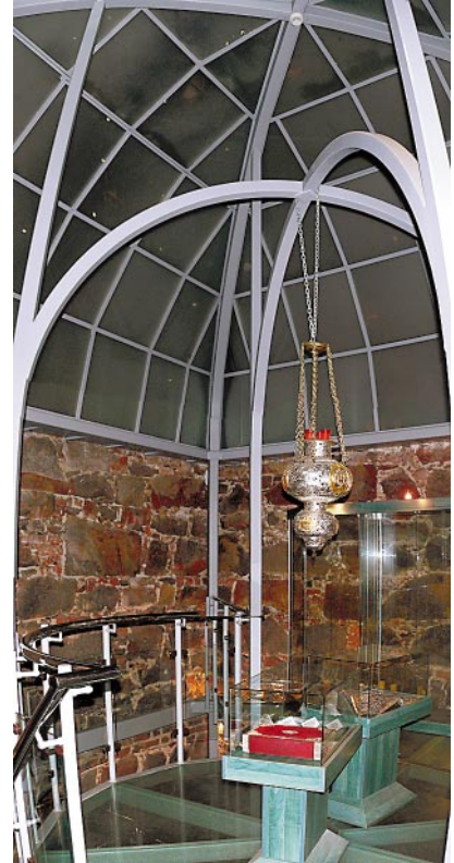
Ryc. 26. Zwieńczenie konstrukcji galerii wystawienniczej przeszklonymi kopułami Fig. 26. Glass domes topping the construction of the exhibition gallery
