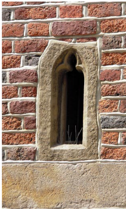
Ryc. 35. Fragment wstępu ceglanego konserwowanego w 2010 roku – widok po zakończeniu prac
