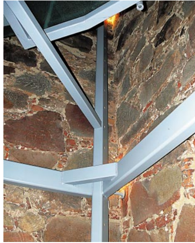
Ryc. 24. Fragment stalowej konstrukcji galerii wystawienniczej wraz z usztywnieniem Fig. 24. Fragment of the steel construction of the exhibition gallery with bracing
