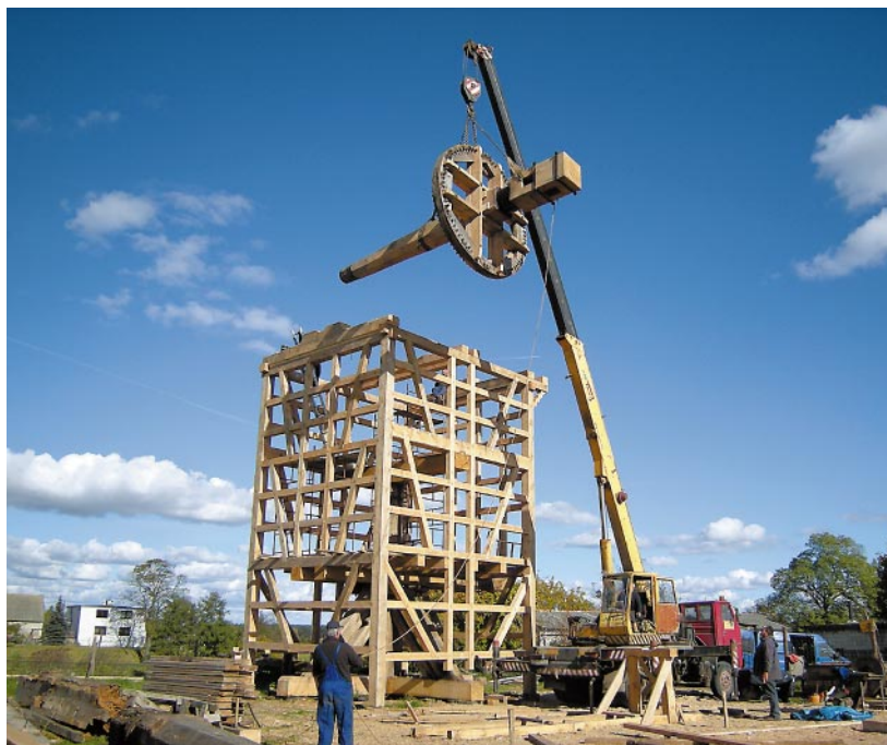
Ryc. 13. Bierzłowo, wiatrak koźlak z 1867 r. Montaż wału głównego z kołem palecznym podczas prac konserwatorskich prowadzonych od sierpnia 2010 (fot. M. Prarat, 2010) Fig. 13. Bierzłowo, post mill from 1867. Mounting of the main shaft with break wheel during conservation work carried out since August 2010 (photo by M. Prarat, 2010)
