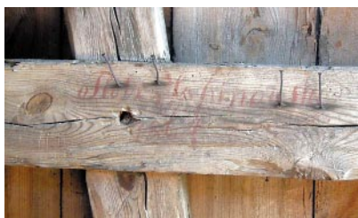
Ryc. 4. Bierzglowo, wiatrak koźlak z 1867 r. Rygiel ściany wejściowej na najwyższej kondygnacji. Napis kredką: Piotr Jasinowski 1867 (fot. M. Prarat, 2010)
