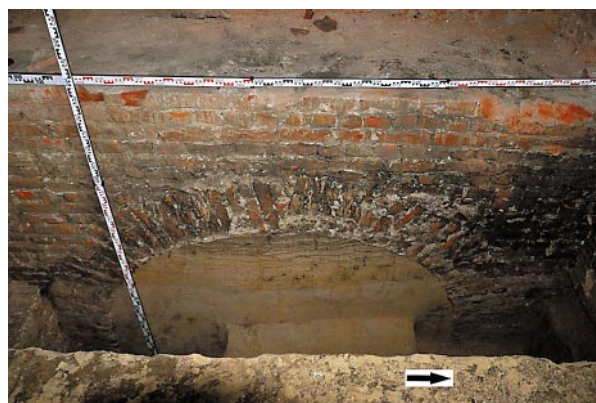
Ryc. 6. Lublin, klasztor powizytkowski, kościół. Wykop 1/10, część W, sonda przy murze W północnej części nawy. Lico muru fundamentowego z łukiem konstrukcyjnym, widok na W. Fot. R. Solski, 14.05.2010 Fig. 6. Lublin, former Visitationist convent, the church. Dig 1/10, part W, test pit by the W wall in the north part of the nave. Face of the foundation wall with a construction arch, view towards W. Photo by R. Solski, 14.05.2010
