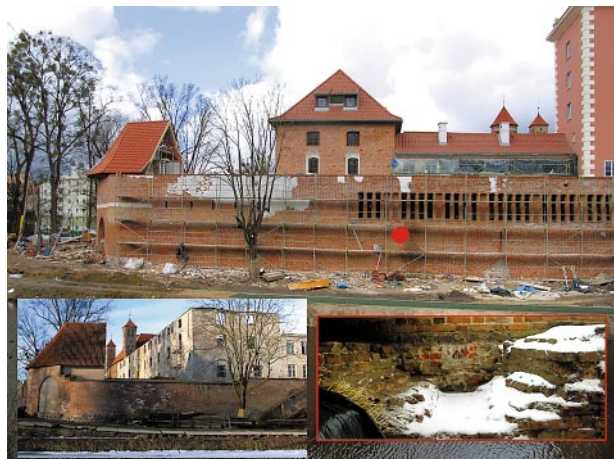
Ryc. 23. Mur zewnętrzny międzymurza południowego w trakcie nadbudowy, z zaznaczoną lokalizacją gotyckiej strzelnicy. W lewym dolnym narożniku ten sam mur przed nadbudową, w prawym dolnym narożniku strzelnica w widoku od strony międzymurza (poziom jej progu zaznaczono kolorem niebieskim). Fot. L. Wawrykiewicz, 2009, 2010 i 2011 23. The outer wall of the south intermural space while raising it, with marked location of the Gothic embrasure. In the bottom left corner the same wall before raising, in the bottom right corner the embrasure in a view from a the side of the intermural space (the level of its threshold was marked in blue). Photo by L. Wawrykiewicz, 2009, 2010 and 2011
