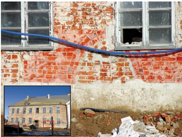
Ryc. 19. Ślad po ostrołukowym otworze drzwiowym w północnym odcinku elewacji dziedzińcowej skrzydła wschodniego (stan po skuciu tynków). Fot. L. Wawrykiewicz, 2010 Fig. 19. Traces of ogival door opening in the northern section of the courtyard elevation in the east wing (state after hacking off plaster). Photo by L. Wawrykiewicz, 2010
