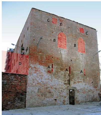
Ryc. 9. Elewacja północna skrzydła zachodniego (od strony suchej fosy), powstałego w fazie II (mury gotyckie zachowane niemal do korony – bez kilku ostatnich warstw), po skuciu tynków. A – strzelnice szczelinowe; B – ostrołukowe blendy piętra, w których znajdowały się otwory zamknięte odcinkiem łuku; C – otwory obronne poddasza; D – pierwotna wysokość kurtyny północnej przedzamcza (ustalona na podstawie analizy narożnika skrzydła zachodniego); E – wtórne otwory z fazy V. Fot. L. Wawrykiewicz, 2010
