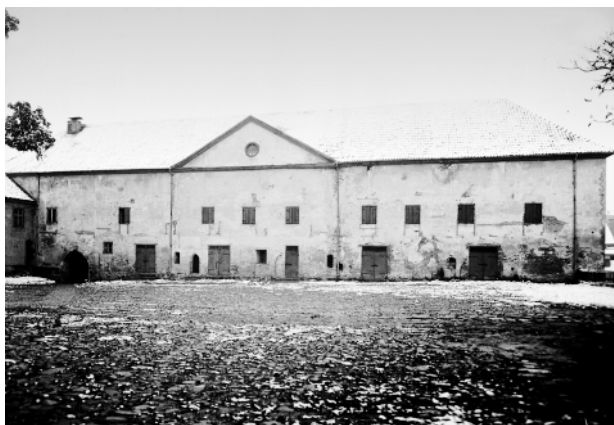
Ryc. 14. Elewacja dziedzińcowa skrzydła zachodniego w 1939 r. (fot. Krauth). Widoczne ślady po gotyckich otworach z fazy II, w tym po otworach drzwiowych pierwszego piętra. Fot. ze zbiorów Instytutu Sztuki Polskiej Akademii Nauk w Warszawie (dalej: IS PAN), nr inw. 56689
