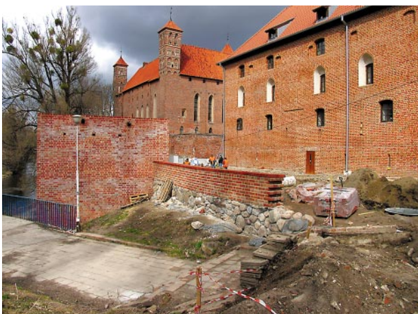
Ryc. 21. Mur zewnętrzny międzymurza zachodniego oraz baszta ustępowa po nadbudowie w ramach adaptacji przedzamcza (mur międzymurza dobiega do późniejszej od niego baszty i jest wykonany z cegły wyłącznie w partii zwieńczenia w formie płytkiego murka). Fot. L. Wawrykiewicz, 2011 Fig. 21. The outer wall of the west intermural space and the privy tower after it was raised during the adaptation of the bailey (the wall of the intermural space adjoins the tower from a later period, and is made from brick only in the part of its coping in the form of a shallow wall). Photo by L. Wawrykiewicz, 2011
