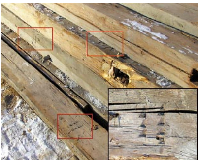
Ryc. 36. Ciesielskie znaki montażowe na zdemontowanych elementach więźby dachowej skrzydła zachodniego. Fot. L. Wawrykiewicz, 2010
