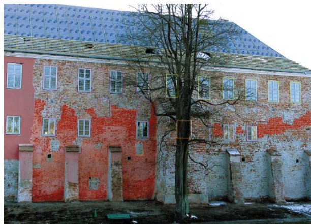
Ryc. 17. Północny odcinek elewacji wschodniej skrzydła wschodniego po skuciu tynków. Kolorem czerwonym podkreślono relikty gotyckie z fazy II. Liniami czerwonymi zaznaczono szwy po gotyckich otworach okiennych z fazy II, jasnozielonymi – z fazy V, jasnofioletowymi – z etapu I fazy VI, pomarańczowymi – z etapu I fazy VII, żółtymi – z etapu II fazy VII. Fot. L. Wawrykiewicz, 2010
