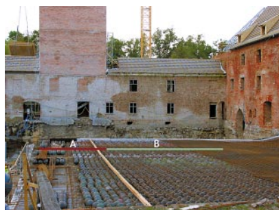
Ryc. 29. Elewacja dziedzińcowa skrzydła południowego po skuciu tynków, w trakcie wykonywania podpiwniczenia dziedzińca. Rozwarstwienie murów fundamentowych: A – mury wieży gotyckiej z fazy I; B – mury z fazy V. Fot. L. Wawrykiewicz, 2010
