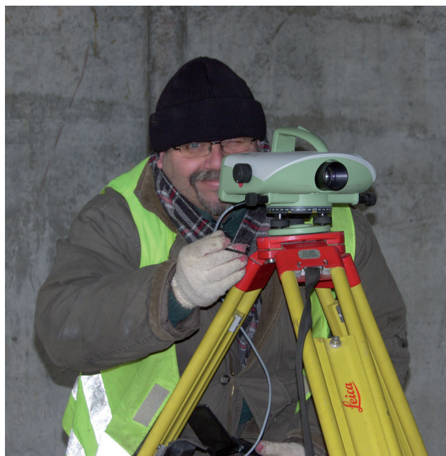
Fot. 5. Pomiar ugięć i przemieszczeń z zastosowaniem niwelacji geometrycznej
