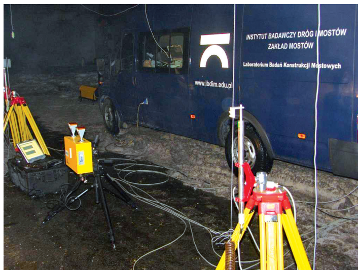
Fot. 7. Ustawienie radaru interferencyjnego pod badanym wiaduktem w ciągu CMK, na pierwszym planie widoczne przetworniki indukcyjne
