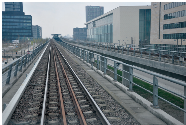
Odcinek metra między stacjami Ørestad i Bella Center, linia M1 (1.05.2010 r.)
