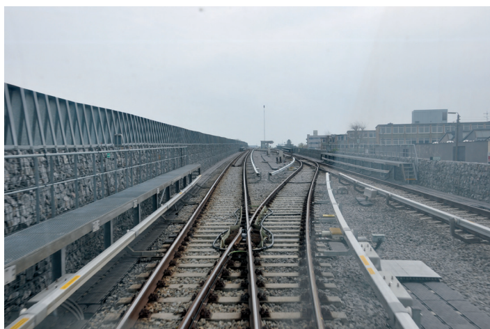
Wjazd do tunelu tuż przez stację Lergravsparken, linia M2 (30.04.2010 r.)
