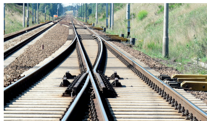
Fot. 4. Krzyżownica z ruchomym dziobem wyposażona w system tradycyjny
