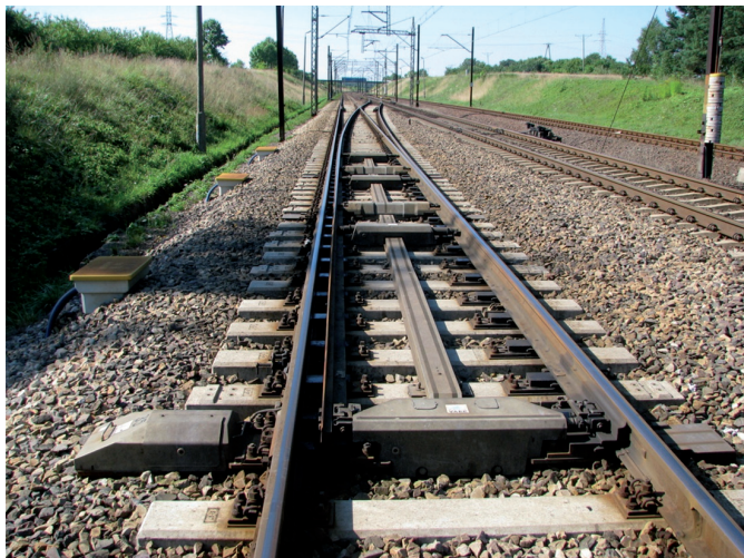
Fot. 1. Zwrotnica wyposażona w system HYDROSTAR
