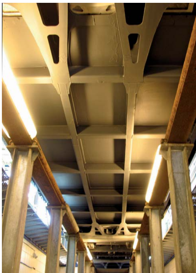
Konstrukcja spodniej części członu wiszącego
