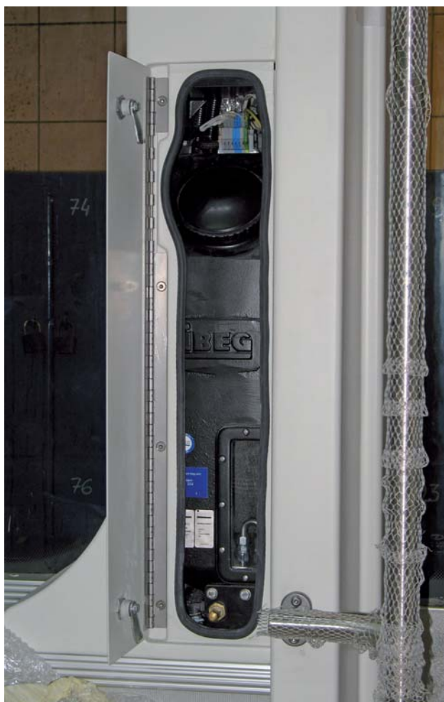
Piasecznice zamontowano przy wręgach w ostonach słupków okiennych
