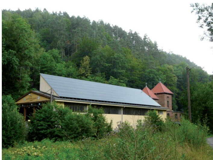
Fot. 5. Panel słoneczny umieszczony na dachu budynku zajezdni tramwajowej Fot. M. Bartłomiejczyk
