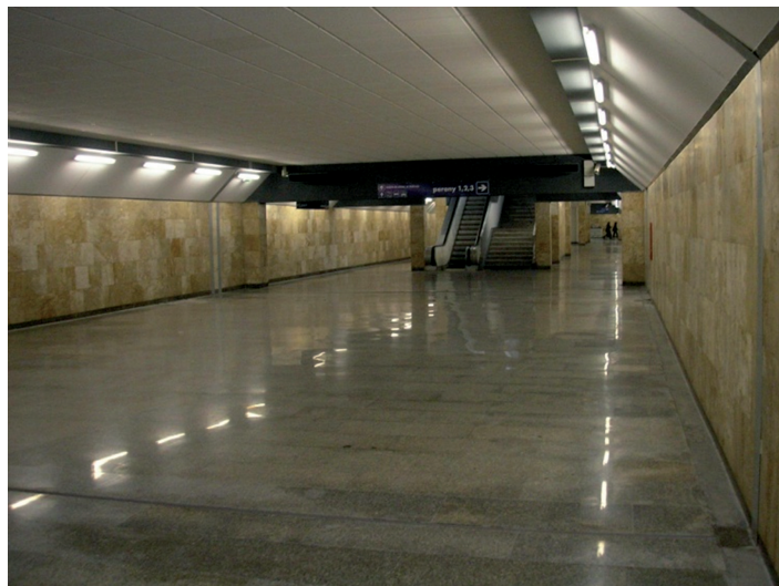
Fot. 9. Odnowiony tunel pod peronem IV, mający pełnić rolę tymczasowego dworca kolejowego w Katowicach (2010)
