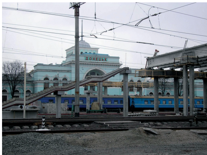
Fot. 8. Budowa estakady dla pasażerów pociągów dalekobieżnych w Doniecku (2011) Fot. M. Rechtłowicz
