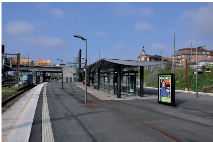
Stacja Dybbølsbro (1.05.2010 r.)
