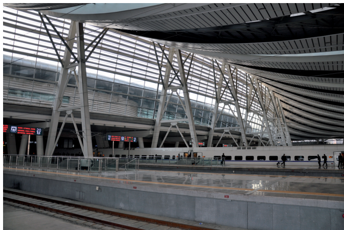
Dworzec Beijing Nan, hala peronowa
