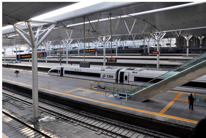
Dworzec w Tianjin, hala peronowa
